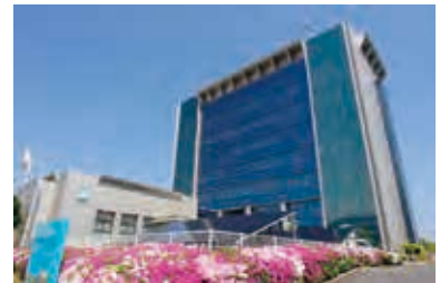
FAISヒューマンメディア 創造センタービル(八幡東区東田)
